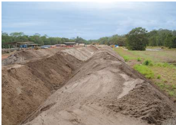
3 Les sols traités sont déplacés vers des emplacements équipés de revêtements spéciaux sur place, permettant ainsi une surveillance continue de la décomposition des hydrocarbures et de la qualité du sol.
