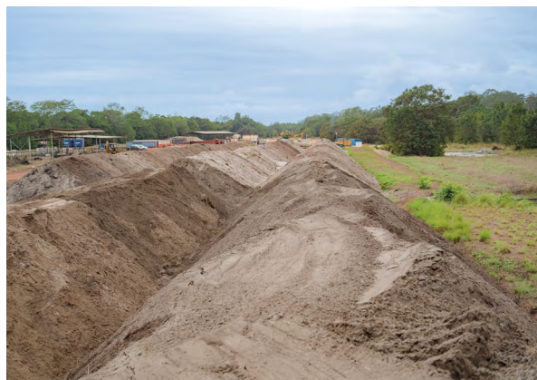
3 Les sols traités sont déplacés vers des emplacements équipés de revêtements spéciaux sur place, permettant ainsi une surveillance continue de la décomposition des hydrocarbures et de la qualité du sol.
