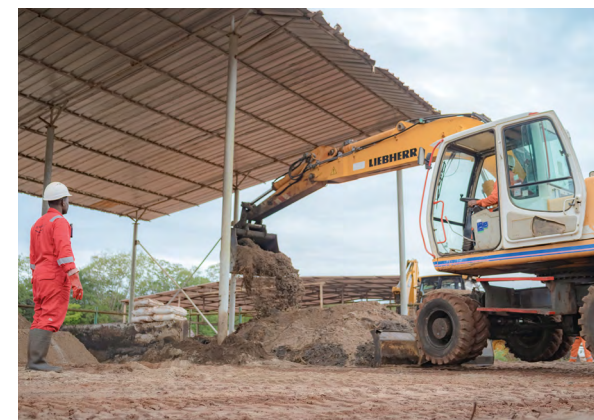
2 Des nutriments sont ajoutés et aérés pour améliorer l'efficacité du processus de traitement.
