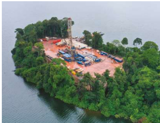
Plate-forme compacte et infrastructures civiles minimales à Ngongui-3 pendant les activités d'E&A.
