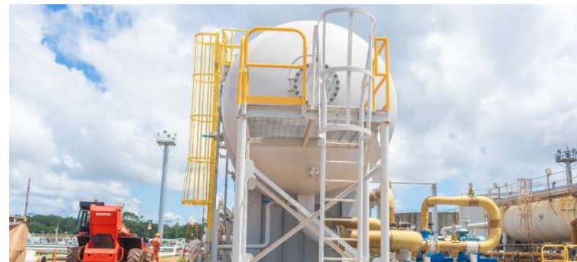
Unité ISF-3 au Terminal de Gamba en novembre 2023.
