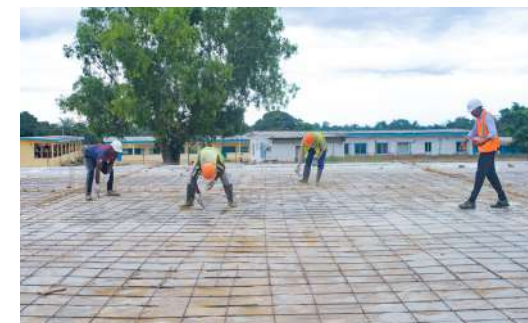
Construction d'un plateau sportif au Lycée de Mandji.
